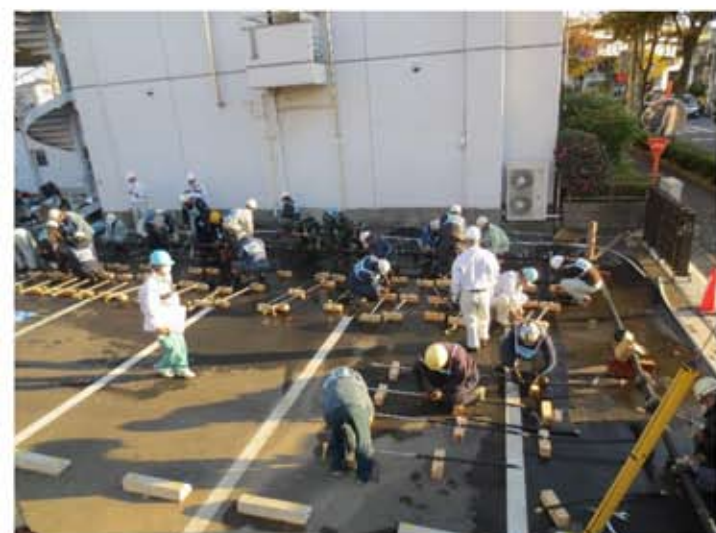
配管・分水栓を取り外し 二次判定へ ②
