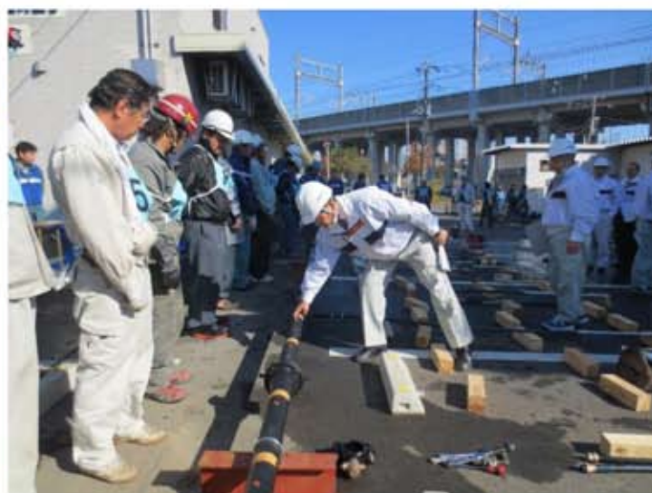
午前実技・二次判定（穿孔・コア挿入等）風景 ②
