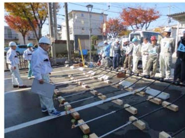
午前実技・一次判定（出来栄え・漏水等）風景 ①
