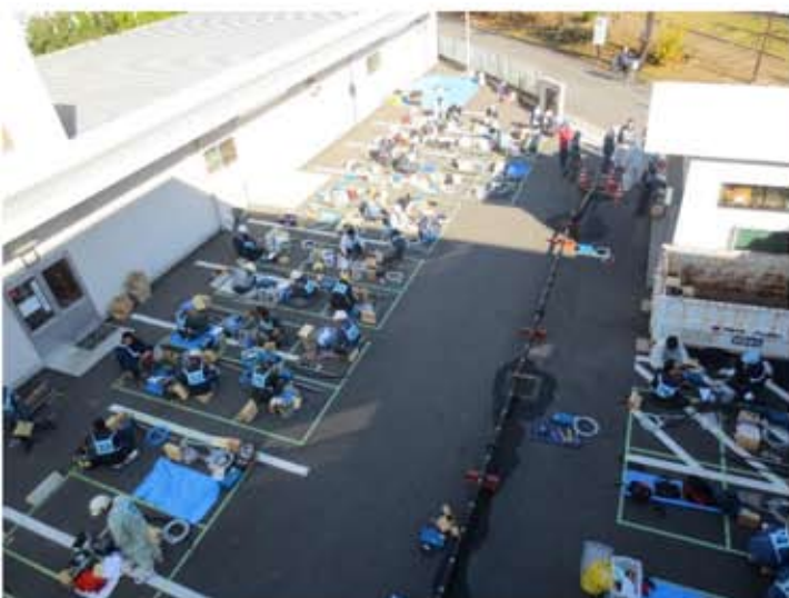
午後の実技風景（偶数の人は先に配管作業を） ①
